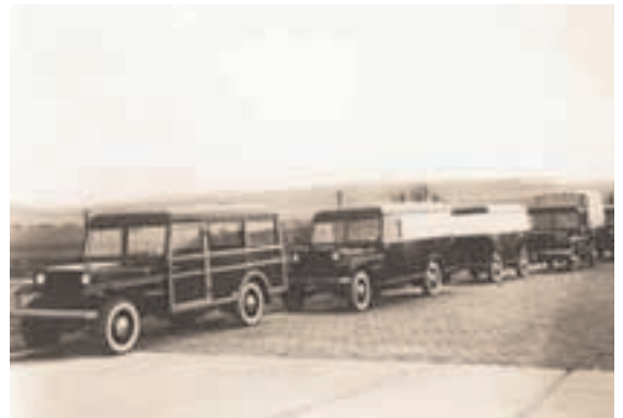
Verschiedene Ausführungen des Jeep-Fahrgestelles (v. l. n. r.): Standardtyp (Lieferwagen, der zu einem Personenwagen mit acht Sitzen umgebaut werden konnte), Eintonner-Kastenlieferwagen mit Anhänger, Eintonnen-Pritschenlieferwagen.
