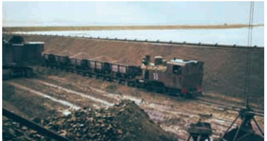
Der Heerter Klärteich, 1965.
