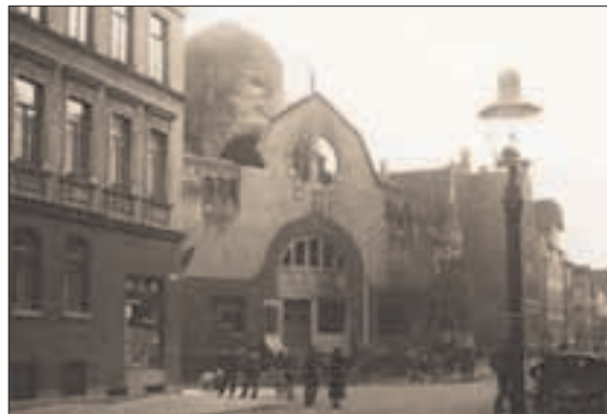
Die ausgebrannte Synagoge am 11. November 1938. Die Mittelturmspitze als zentrales tragendes Element hatte dem Feuer standgehalten.
