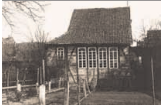
Die Alte Synagoge im Garten des Hauses Damm 12.
