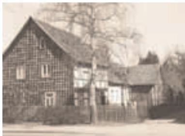
Streckhof, um 1800 erbaut.
